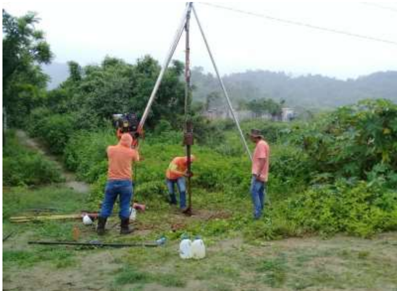
VISTA DE LA PRFORACION
