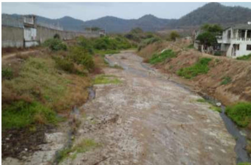
CANAL DEL RIO
