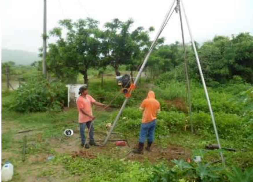
INSTALACION DE LOS EQUIPOS DE SPT
