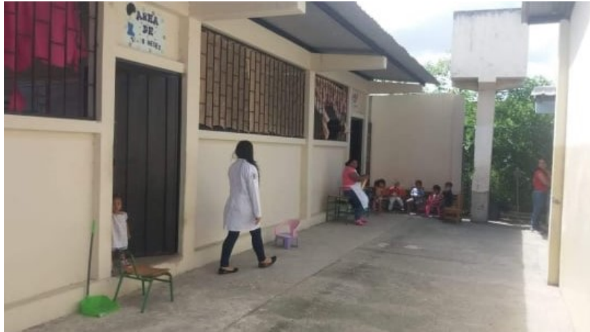
Revisión de las instalaciones del “CDI”.
