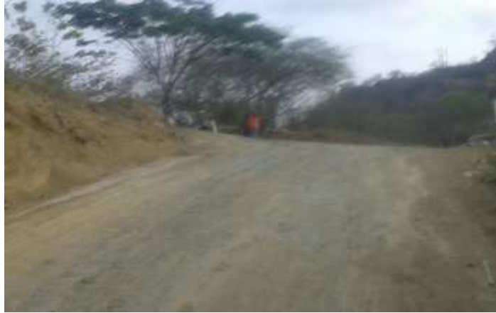
Imagen 3 inicio del intercambio de vía comienzo de la capa de rodadura
