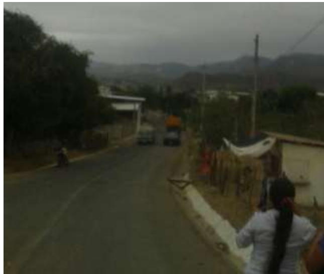
Imagen 4 Prolongación de la capa de rodadura asfáltica
