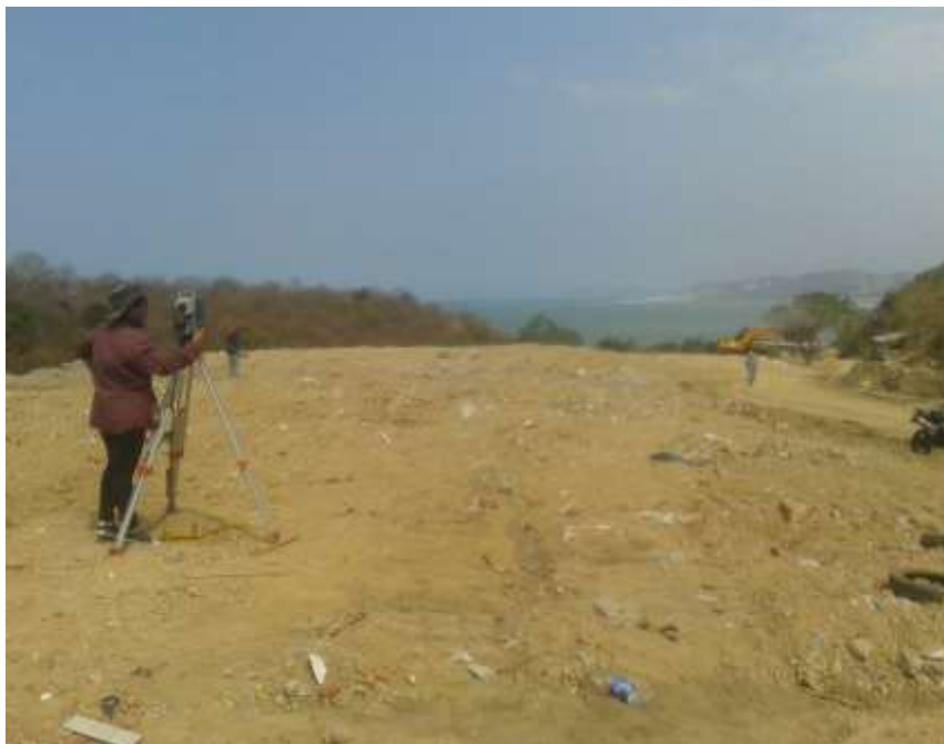
Imagen 31 Toma de puntos en el Eje de la Vía Bello Horizonte La Fanca
