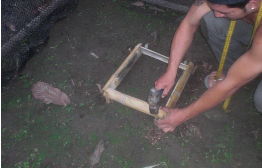
Foto 3. Construcción de platabandas
