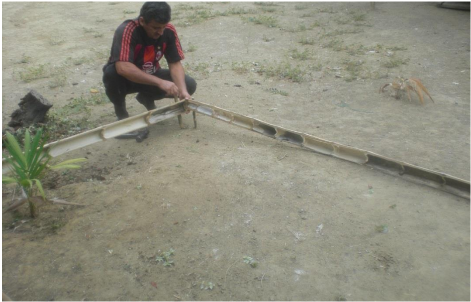
Foto 2. Construcción del Semillero
